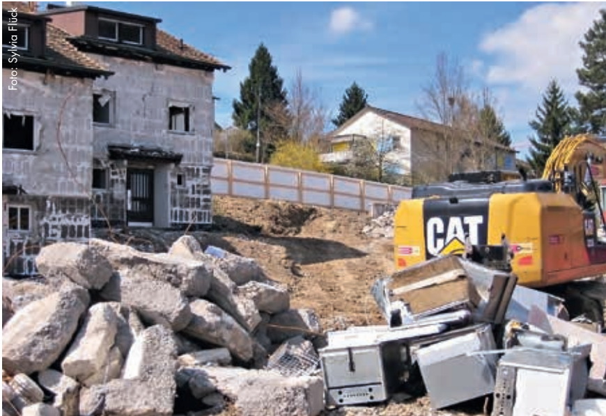
Eindruck von den Abreissarbeiten an der Regulastrasse.
