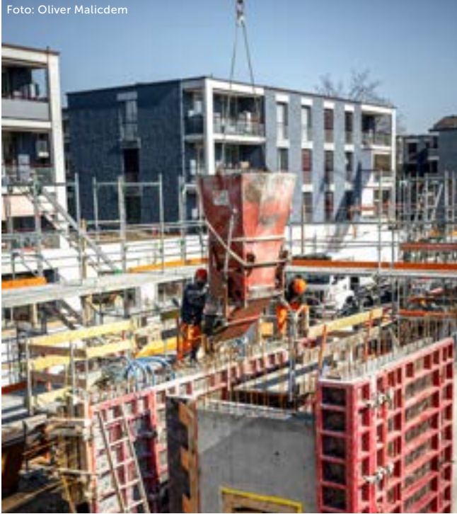
Betonieren für den Neubau.
