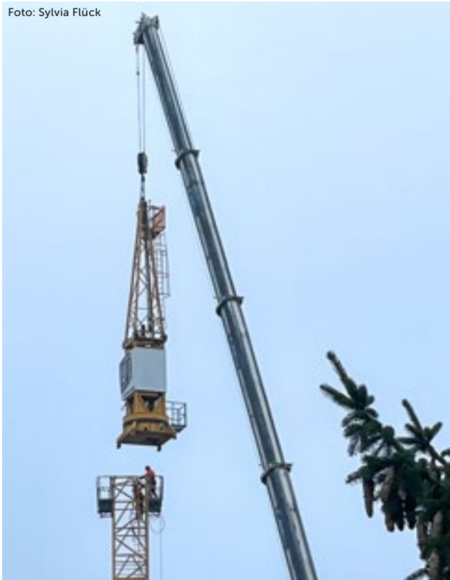
Kranabbau kurz vor Weihnachten auf der Baustelle für den Neubau.
