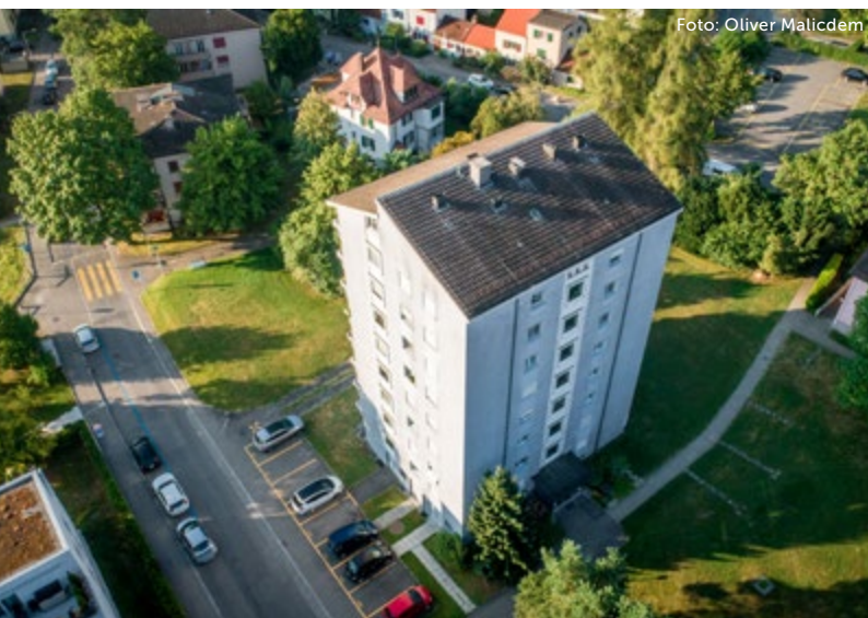
Im Punkthaus an der Riedenhaldenstrasse 95 wird diesen Frühling die Heizung erneuert.
