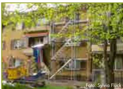
Der Gerüstbau für die Sanierung der Glaubtenstrasse 1 und 3 hat begonnen.
