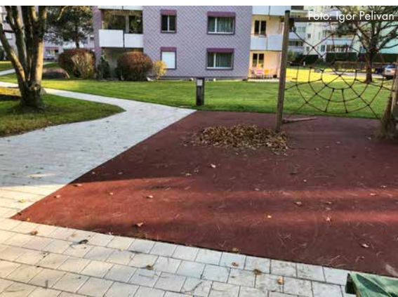
Die Wege in Langnau am Albis nach der Sanierung.
