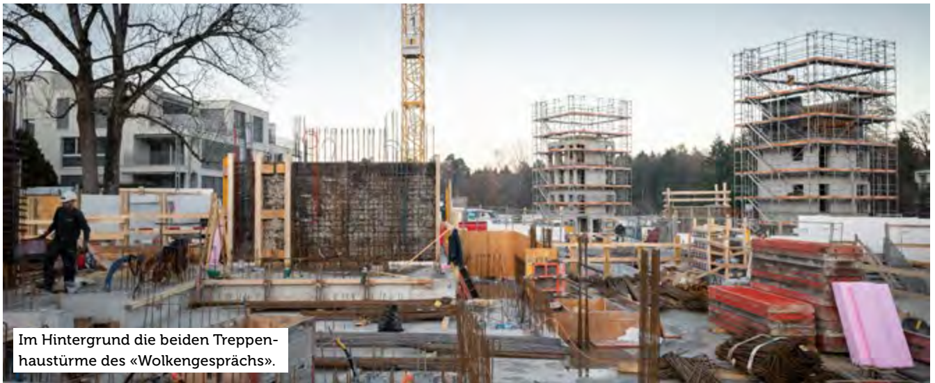
Überblick über die Baustelle des Projekts «dihei». Im Vordergrund der auf Stangen abgestützte Deckel der Tiefgarage. Stand: Ende November 2020.
