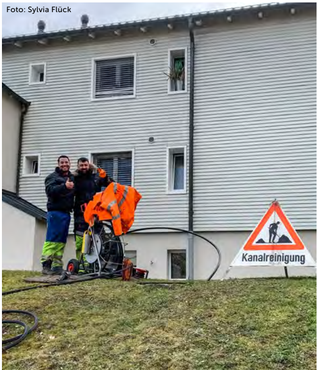
An der Regulastrasse 31–53 fand eine Kanalisationssanierung statt
