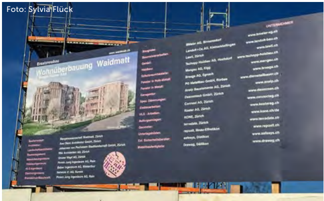
Plakat für den Neubau mit den ausführenden Unternehmen
