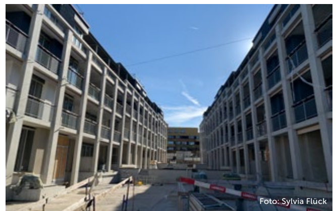
Die Wohngasse zwischen den Häusern C und D des Projekts «dihei» nach dem Gerüstabbau.
