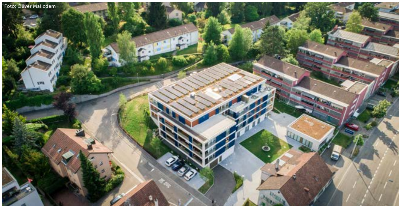
Blick auf die Siedlung 3: Links oben die vier ansteigenden weissen Häuser Regulastrasse 31–37, rechts davon die Reihe mit den Häusern Regulastrasse 39–53 (blaue und gelbe Läden), oben rechts die roten Häuser Wehntalerstrasse 475–501. In der Bildmitte der Neubau Regulastrasse 6 (Siedlung 15), wo sich die Geschäftsstelle der BGW befindet.
