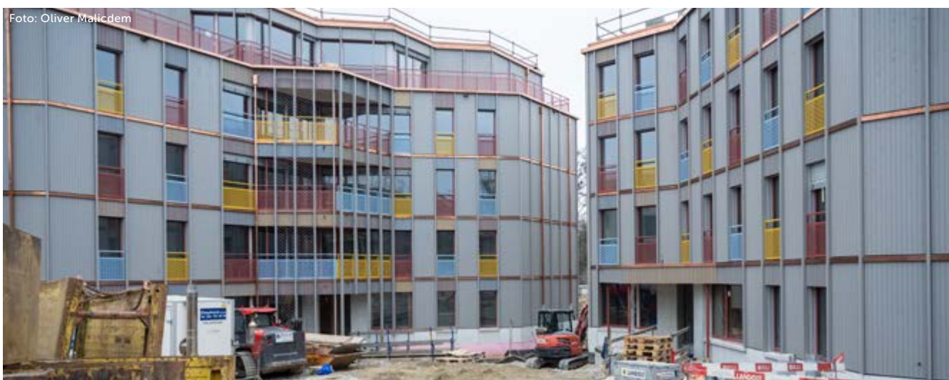
Das Gerüst bei den Häusern A und B (Projekt «Wolkengespräch») ist entfernt. Nun werden die charakteristischen farbigen Elemente an der Fassade sichtbar.
