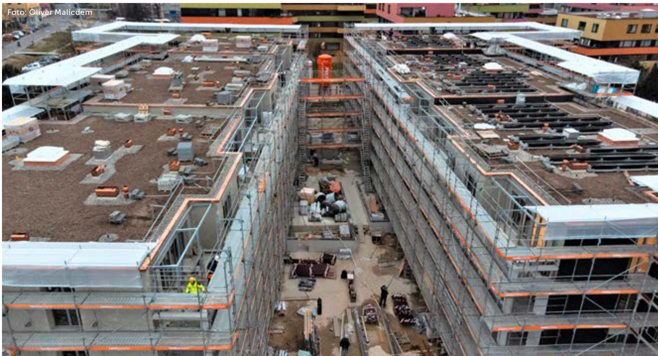
Die Arbeiten an den Häusern C und D (Projekt «dihei») laufen auf Hochtouren.
